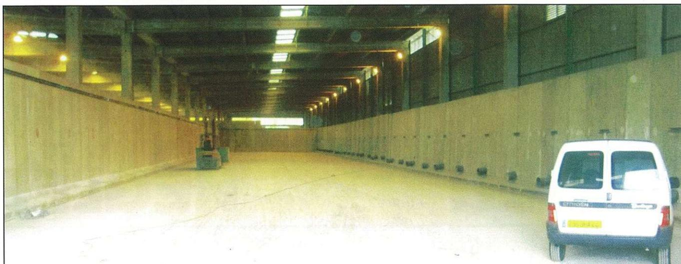
Hangar de stockage couvert avec sol bétonné et murs à emboîtement auto stables et mobiles
